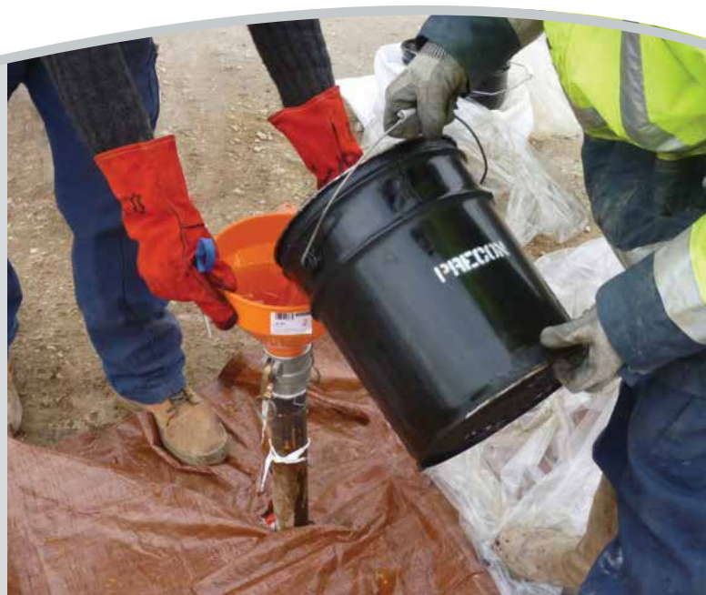
Trenton Pre-Con™ atténue la corrosion qui pourrait être générée par l'eau résiduelle dans la gaine.
